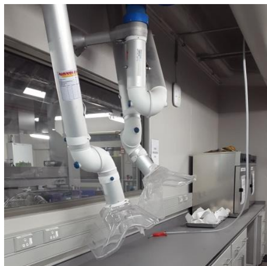
Figura 5 – Sistema de brazos móviles para extracción de polvo en suspensión
