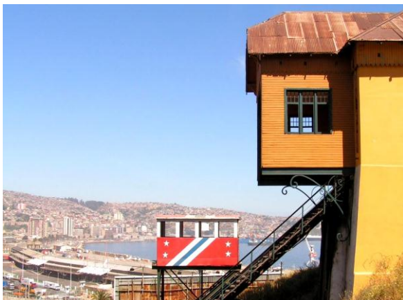
Foto 18: Ascensor Barón, Valparaíso.
