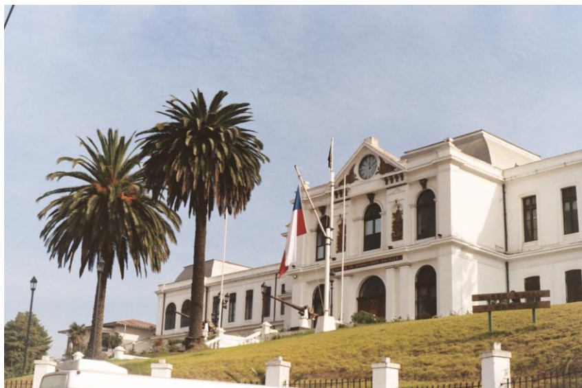
Foto 9: Frontis edificio “Vicealmirante Luis Uribe Orrego”, ex sede de la Escuela Naval de Chile. Valparaíso.
