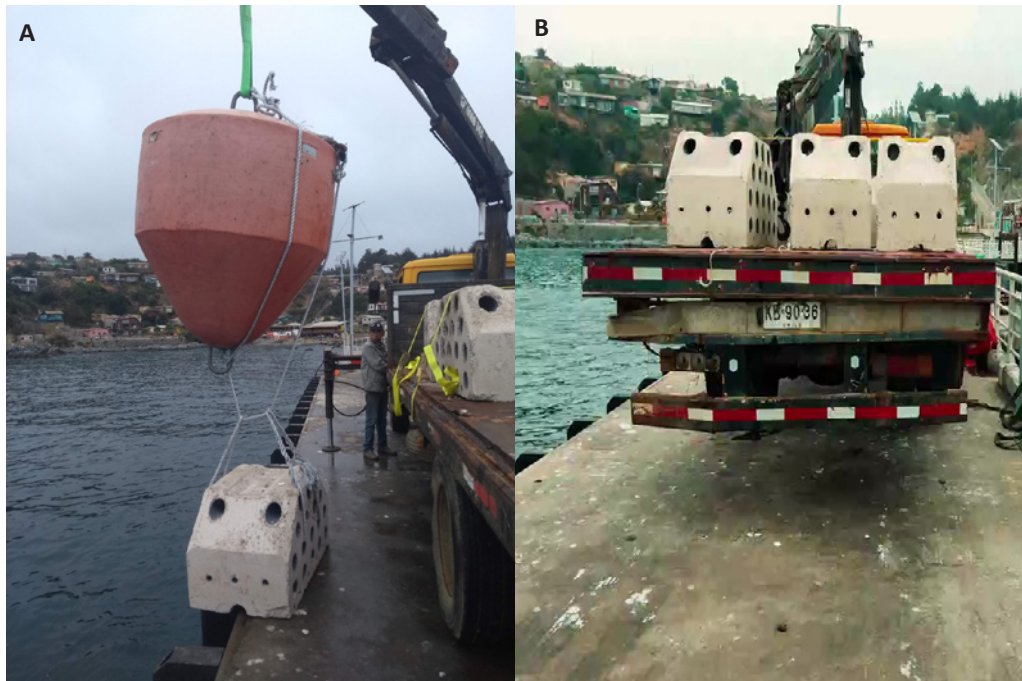
Figura 3.3. A) Traspaso del AATN desde el camión al muelle. B) Descenso de arrecife al mar, unido a una boya de levante, para facilitar su traslado al lugar de fondeo.
