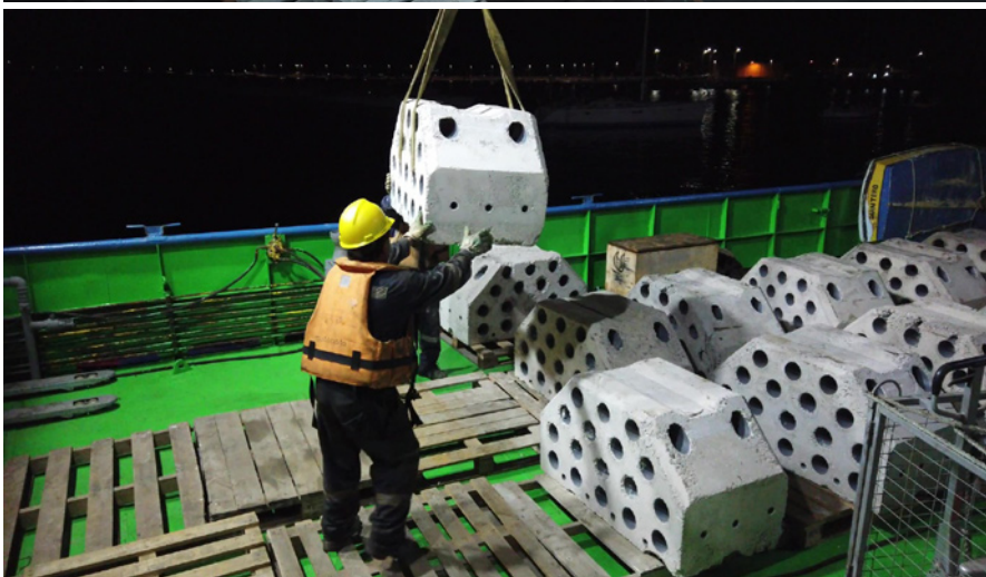
Figura 3.5 A, B y C: Posicionamiento de AATN en barcaza para su traslado a AMERBs de Caleta Maitencillo
