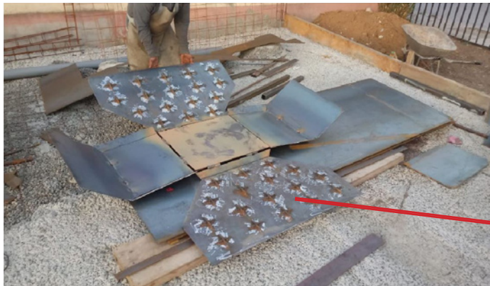
Figura 2.5. Molde extendido, las cruces sirven de apoyo a los tubos transversales.
