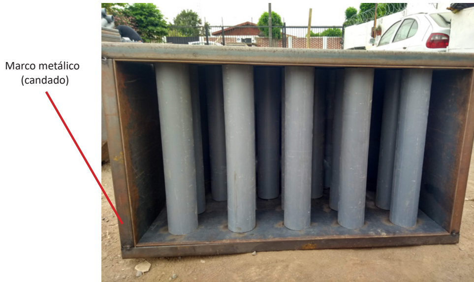
Figura 2.8. Molde apoyado sobre uno de sus costados mas grandes y tuberías transversales T3 instaladas.
